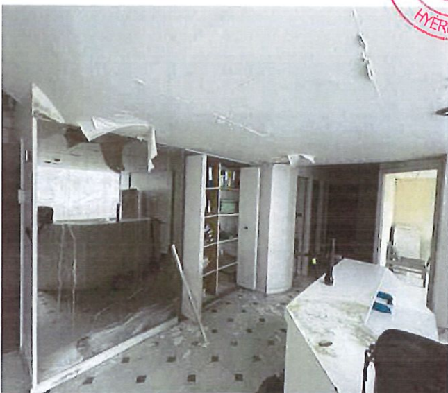
11/ Cellule 15, Entrée des locaux
