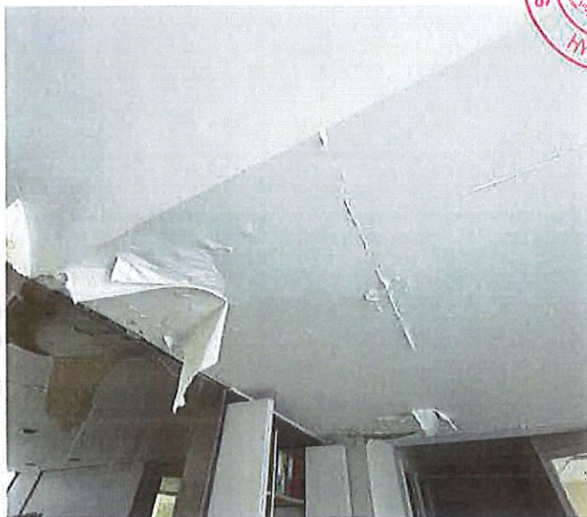
5/ Cellule 15, Entrée des locaux
