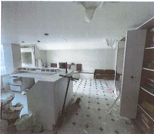
1/ Cellule 15, Entrée des locaux
