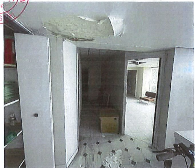
6/ Cellule 15, Entrée des locaux
