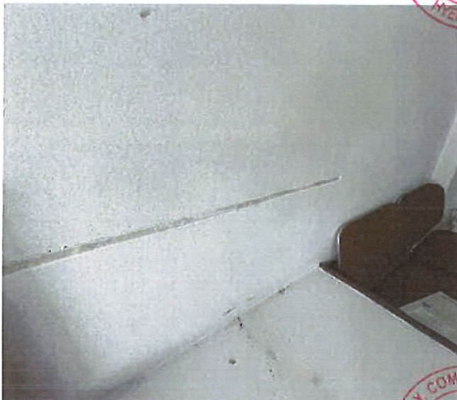
9/ Cellule 15, Entrée des locaux
