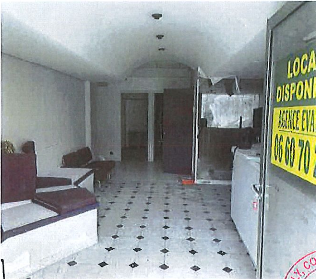
1/ Cellule 15, Entrée des locaux
